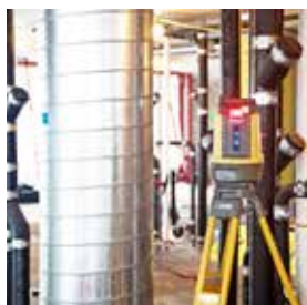
机电、管道、建筑外墙安装
