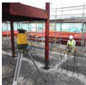
地基浇筑、打桩、管线预埋
