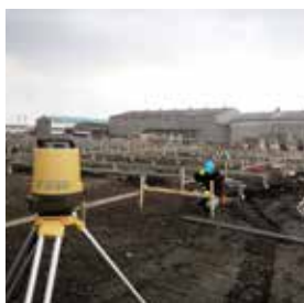
太阳能板安装
